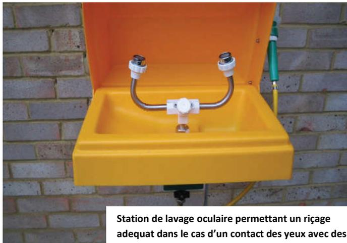
Station de lavage oculaire permettant un rinçage adéquat dans le cas d'un contact des yeux avec des produits chimiques
